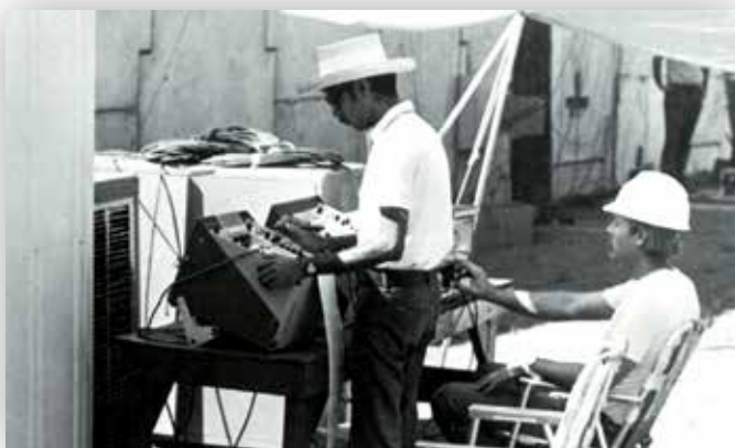
Muro instrumentado de Milville, Nueva Jersey (EE. UU.), 1983
