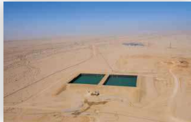
Depósitos de agua de Trekkopje (Namibia)
