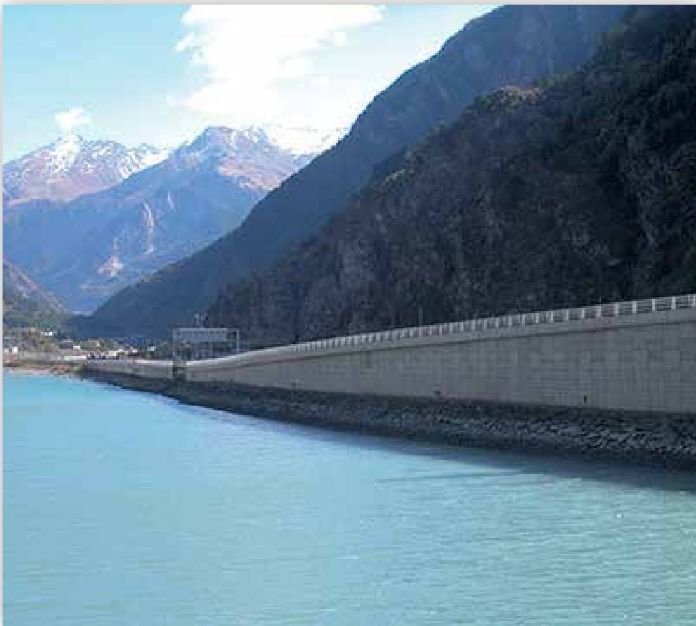
Muros de contención de la autovía A 43 (Francia), 1998
