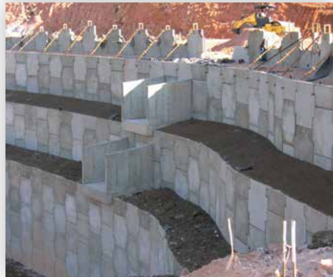
Muro de Mbabane, Suazilandia (Sudáfrica)
