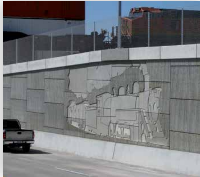
Paramentos arquitectónicos, Gregory, Texas (EE. UU.)
