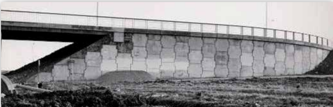
Primer muro con escamas de hormigón, Poitiers (Francia), 1970
