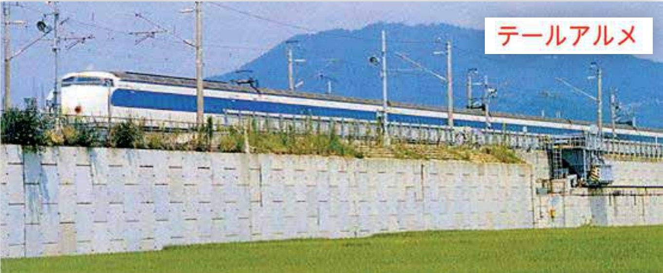
Muros de contención Shinkansen Ohmihachiman (Japón), 1987
