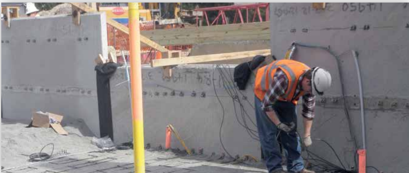
Proyecto conjunto de I+D de Terre Armée y Menard en Bass River, Nueva Jersey (EE. UU.)
