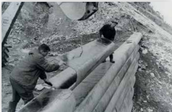
Revestimiento metálico (a la izquierda) comparado con un revestimiento de escamas de hormigón (a la derecha)
