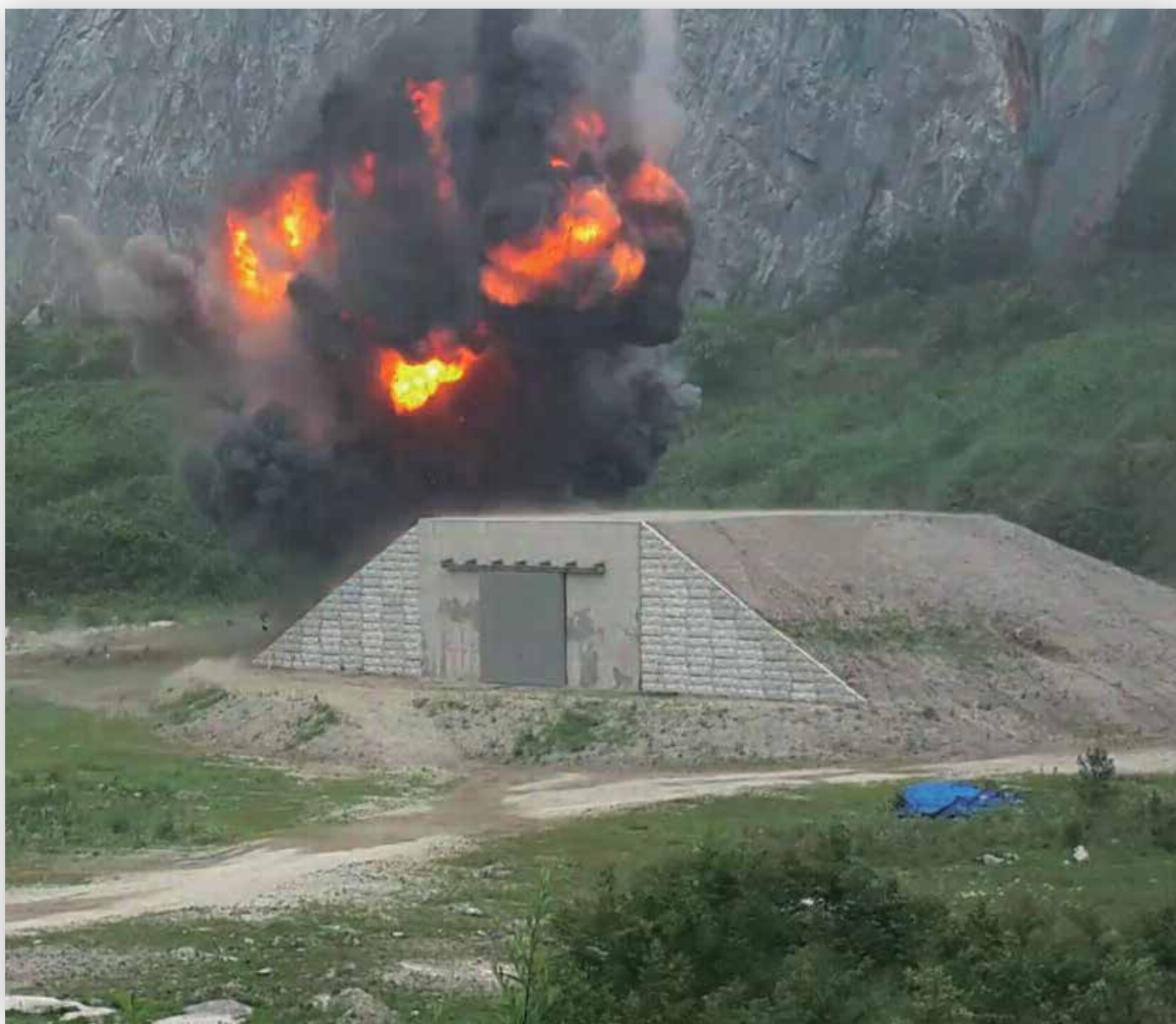
Prueba de resistencia a las explosiones de un silo de almacenamiento de munición
