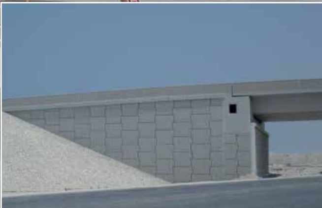
Rampas de acceso al aeropuerto de New Doha (Qatar)
