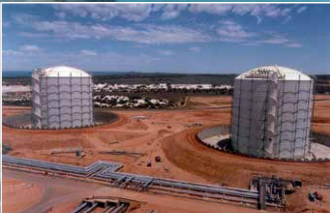
Diques de confinamiento secundario de Stony Point (Australia)
