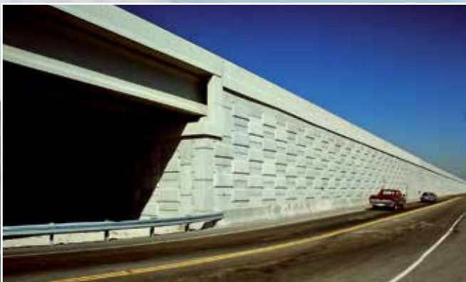
Autovía I-95, Sterling Boulevard, condado de Broward, Florida (EE. UU.)
