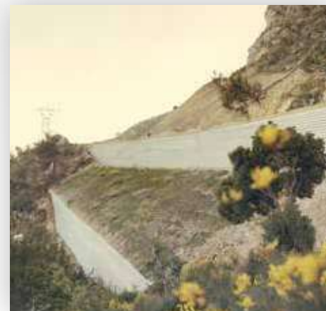
Autovía A53, muro de Peyronnet (Francia), 1968
