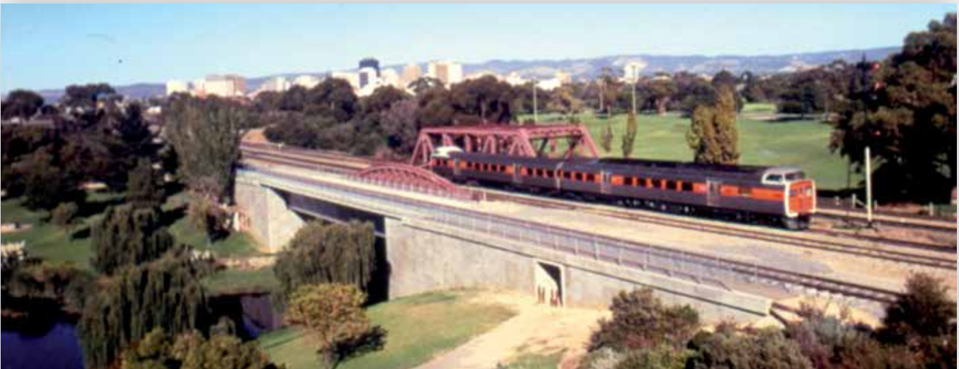
Estribos de puente y muros de contención que soportan las vías, río Torrens (Australia), 1982
