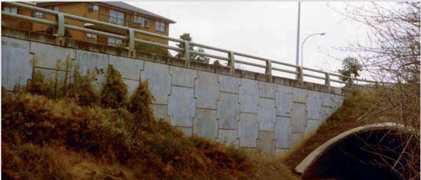
Primer muro de Australia de Tierra Armada®, St. Smith (Australia), 1975
