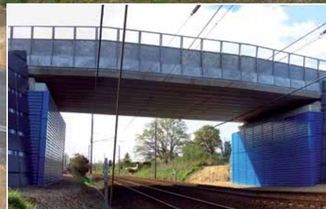
Estribos portantes, Saint-Étienne de Montluc (Francia)
