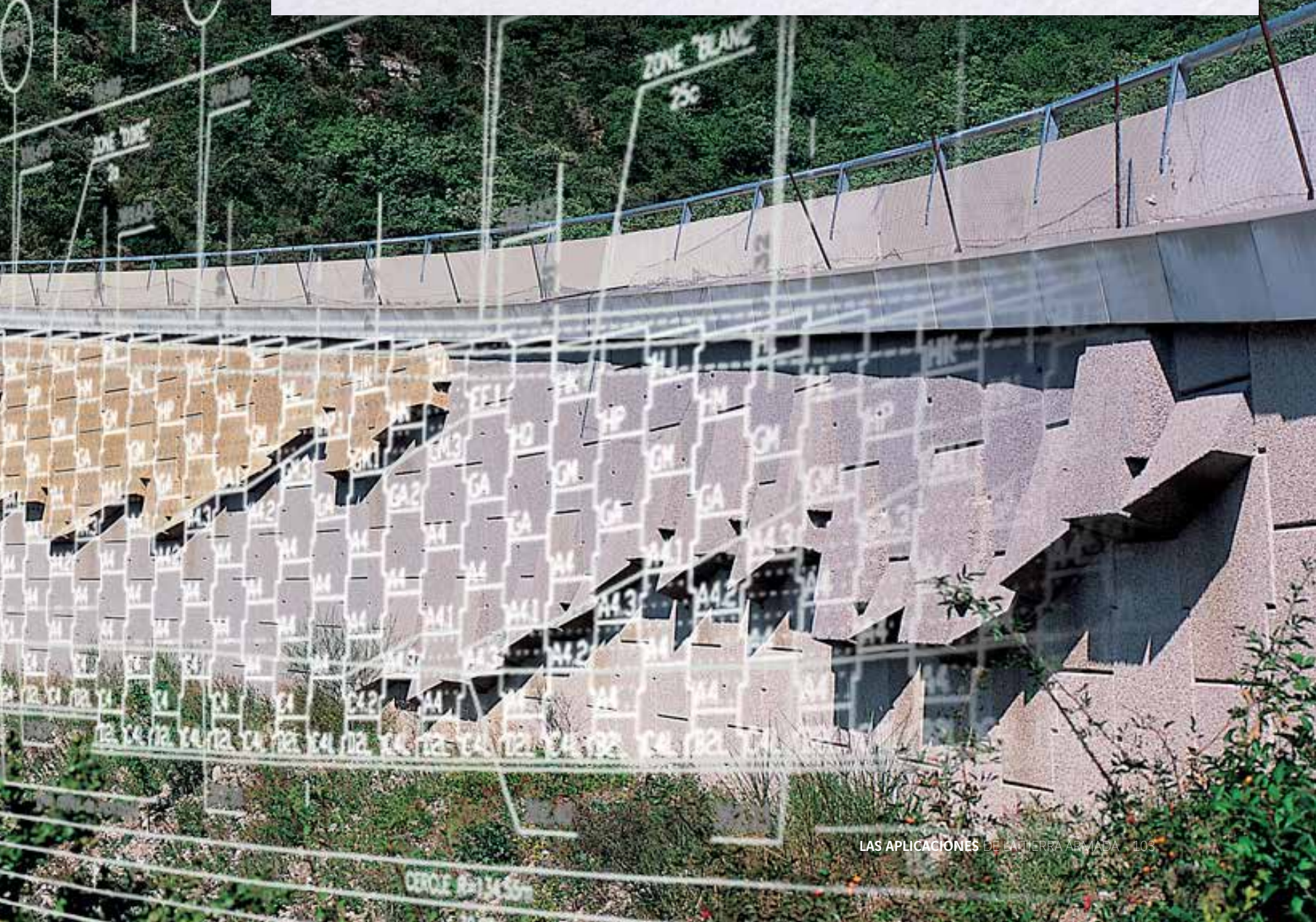
Muro de contención, Dordoña (Francia). El proyecto de la autovía A89 entre Mussidan y Périgueux ha supuesto la construcción de seis muros de contención de TerraClass con un tipo de paramento arquitectónico denominado «A.S.F» (autovías del sur de Francia), el más largo de ellos de 1240 m.
