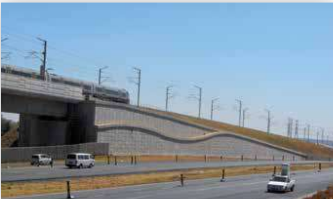
Muro de contención para las vías férreas del proyecto Gautrain Rapid Rail (Sudáfrica), 2010
