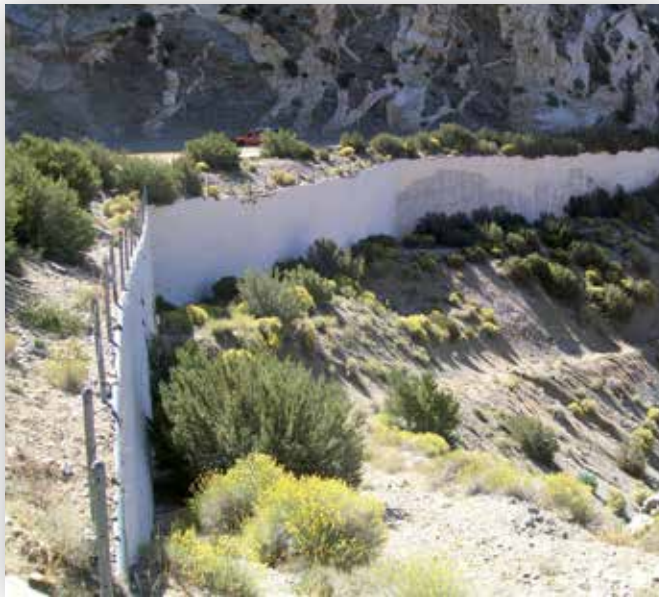
Primer muro de Tierra Armada® de los Estados Unidos: Autovía 39, Parque Nacional de Los Ángeles, California (EE. UU.), 1971
