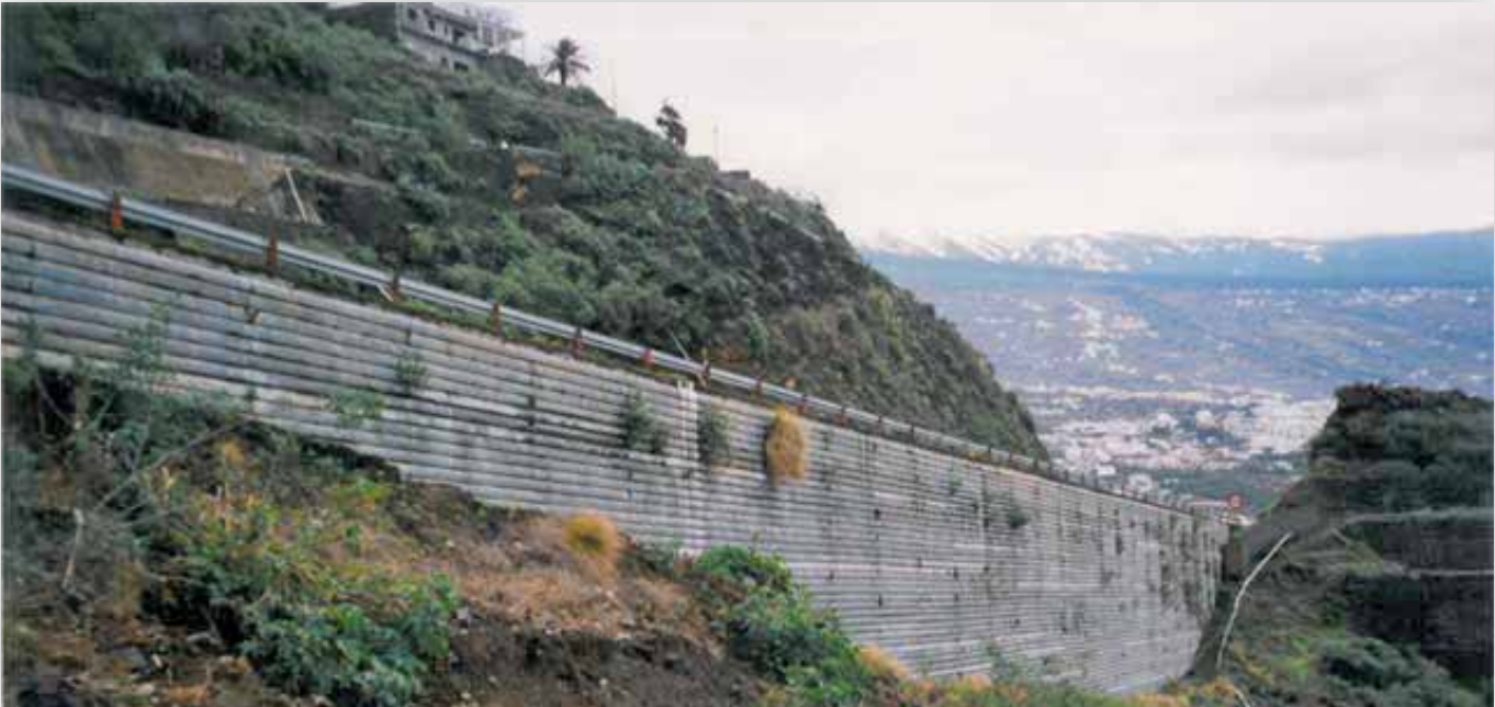
Primer muro de Tierra Armada® de España: Puerto de la Cruz, en la isla de Tenerife (España), 1971
