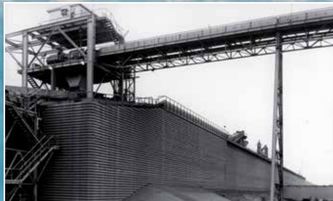
Muros paralelos de un muelle de descarga de carbón, puerto de Dunkerque (Francia), 1977
