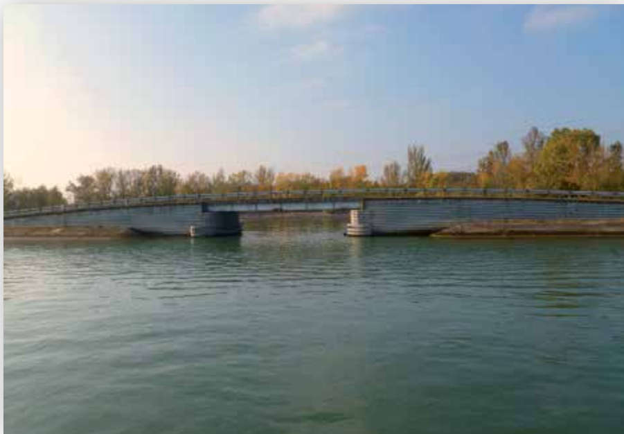
Estribos de puente Estrasburgo (Francia), 1969
